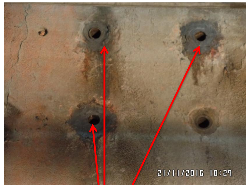
Восстановленные из смолы отверстие и втулка
